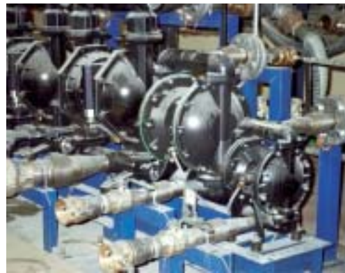
ARO membránové čerpadlá dopravujú zo skladu farby a laky.
