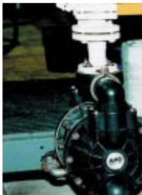
ARO membránové čerpadlá sa používajú na transport viacerých druhov kyselín.
