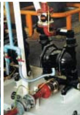
ARO 2" membránové čerpadlá používané v lakovníach.
